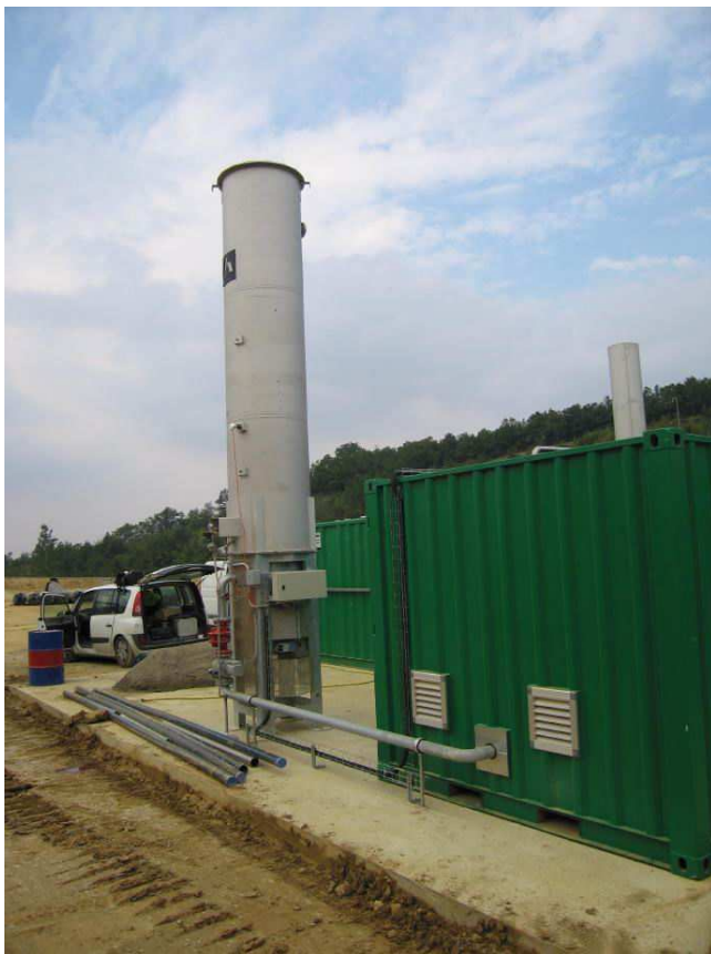
Kompakte Entgasungsanlage im Container HOFGAS® - Ready/C 300
