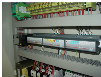
Clip Fernüberwachungssystem im Steuerschrank
